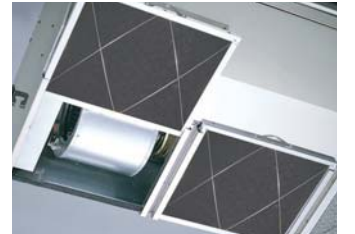
Filtre, tutma yerlerinden çekilerek kolayca dışarıya çekilebilir
